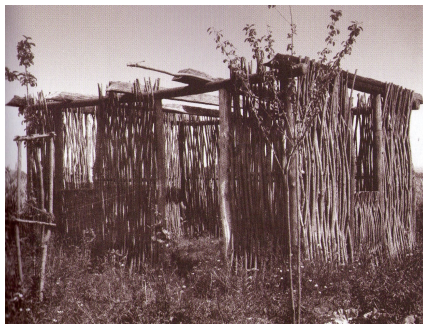
15. ábra Cölöpvázás épület függőlegesen font sövényfallal.
