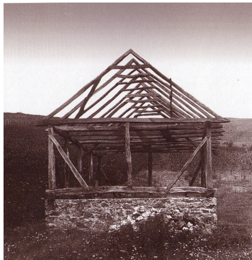
16. ábra Talpas-vázás ház szerkezete.
