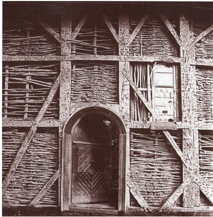
17. ábra Sövényfalú templom talpas-vázás szerkezettel.
