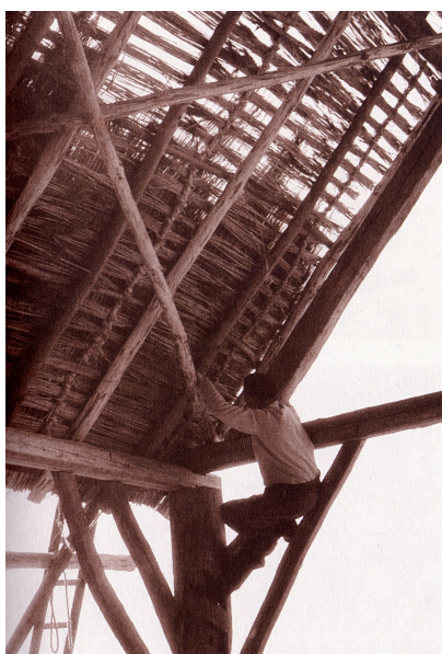
14. ábra Lészás nádtető készítése.
