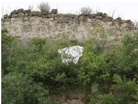
32. ábra: A kőfalon tátongó nyílás olyan, mintha egy a falnak támasztott amorf tárgy lenne. Az illúzió okát a látszólagos tónusértékkülönbségben kell keresnünk (értsd: szimultánkontraszt).
